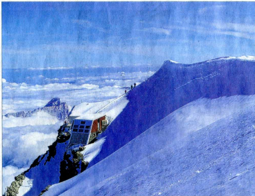
À 200 mètres du nouveau refuge du Goûter, l'ancien est toujours en place, cinq ans après. Son annexe sert de volume recueil avec une procédure d'évacuation particulière depuis le bâtiment en service, encadrée par des professionnels de la montagne. Photo Le DU/Antoine CHANDELLIER
