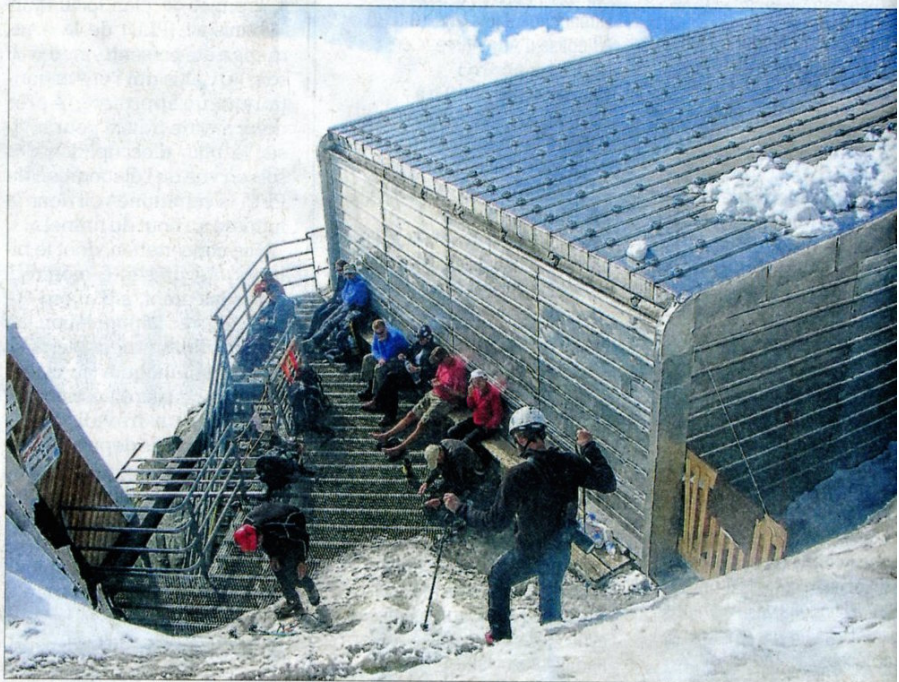
L'ancien refuge, ici en 2009. Le nouveau refuge, situé un peu plus haut, avait pris la relève en 2013.
