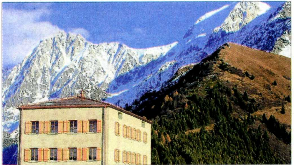
L'hôtel Bellevue devra être mis en conformité - par rapport au permis de construire délivré par la mairie en 2008- d'ici un an. Archives photo Le DL/G.Y.
